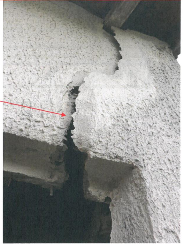
Sur les façades du bâtiment en bordure de la parcelle voisine, ouvertures, fissure et lézarde visualisées
